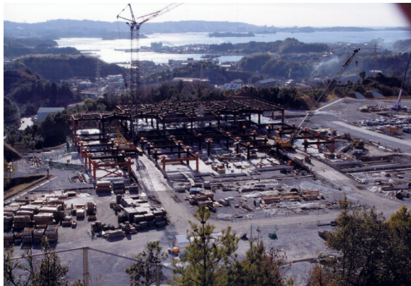
工事中の紀南病院 (平成 14 年末)
